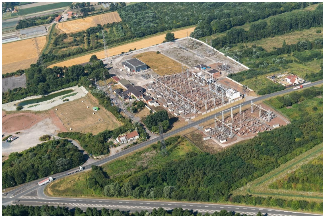
Poste électrique THT de Grande-Synthe, vue aérienne.
