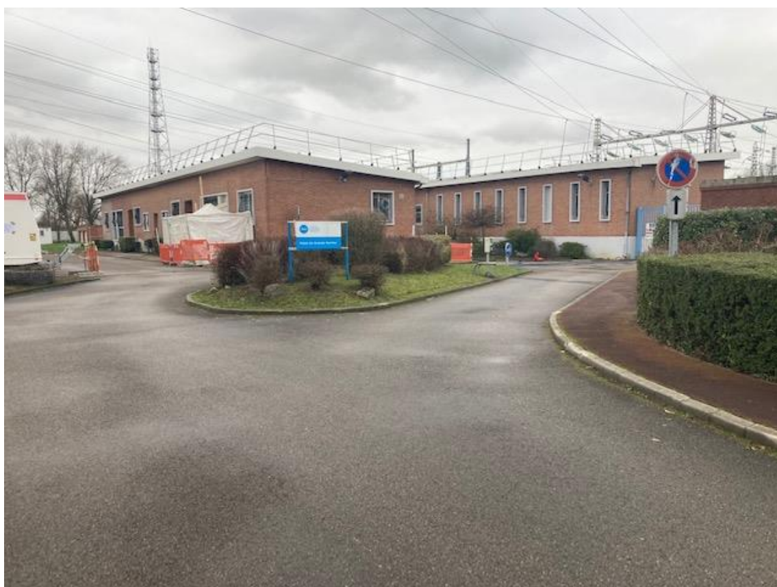
Bâtiment du groupement de poste électrique RTE de Grande-Synthe pouvant accueillir en marge de ses faux-plafonds les gîtes à Chiroptères.
